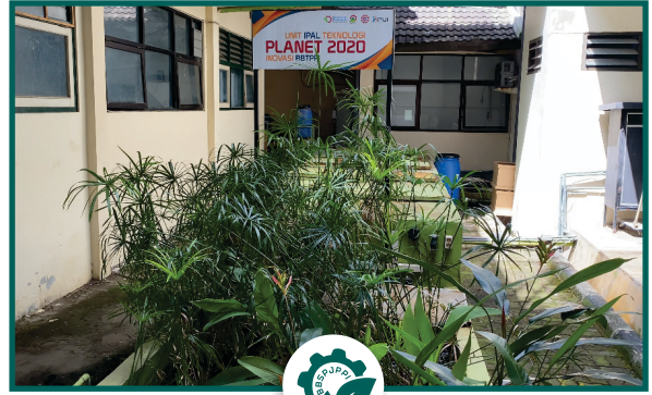
Instalasi Pengolahan Air Limbah (IPAL)
